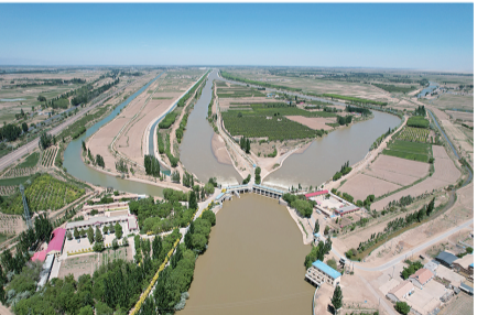
总干渠第一分水枢纽
