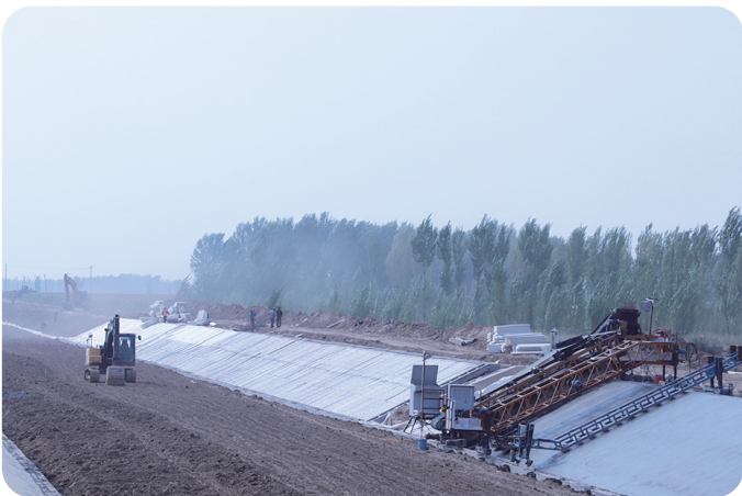
丰济干渠施工现场
