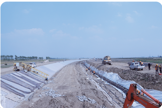
义和干渠施工现场
