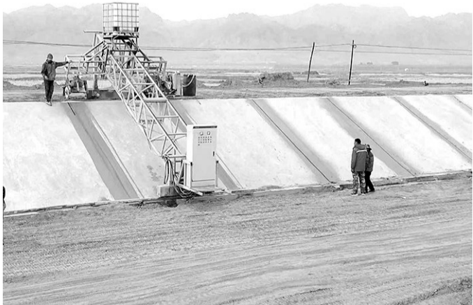
打造精品工程
